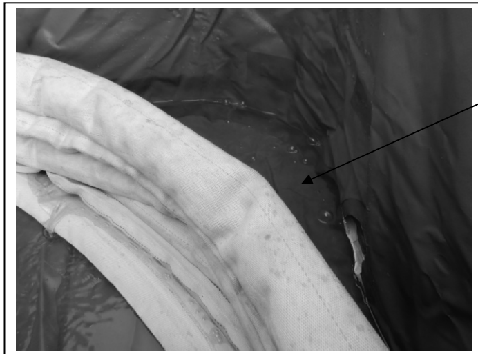
(写真⑤) 水止めの効果実証実験
