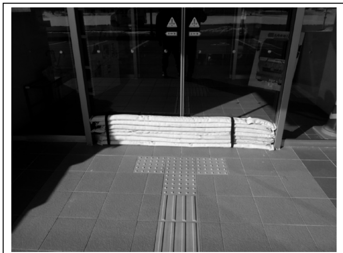
(写真③) 玄関の設置例(1)
